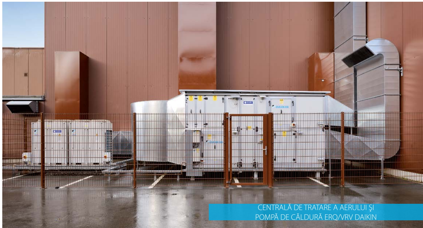
VAM - VENTILARE CU RECUPERARE A CĂLDURII
