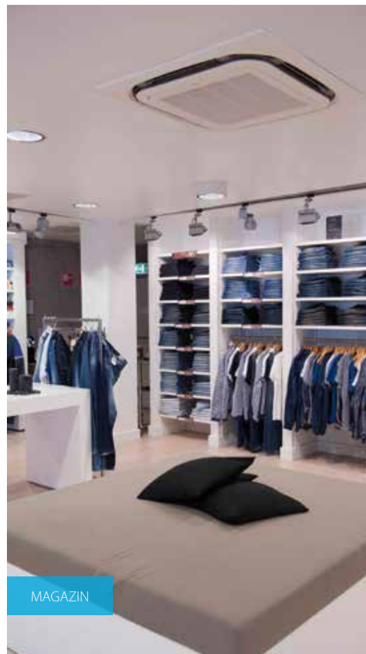
Unitate tip casetă cu jet circular FXFQ-A: Refulare a aerului pe 360° pentru eficiență și confort optime
